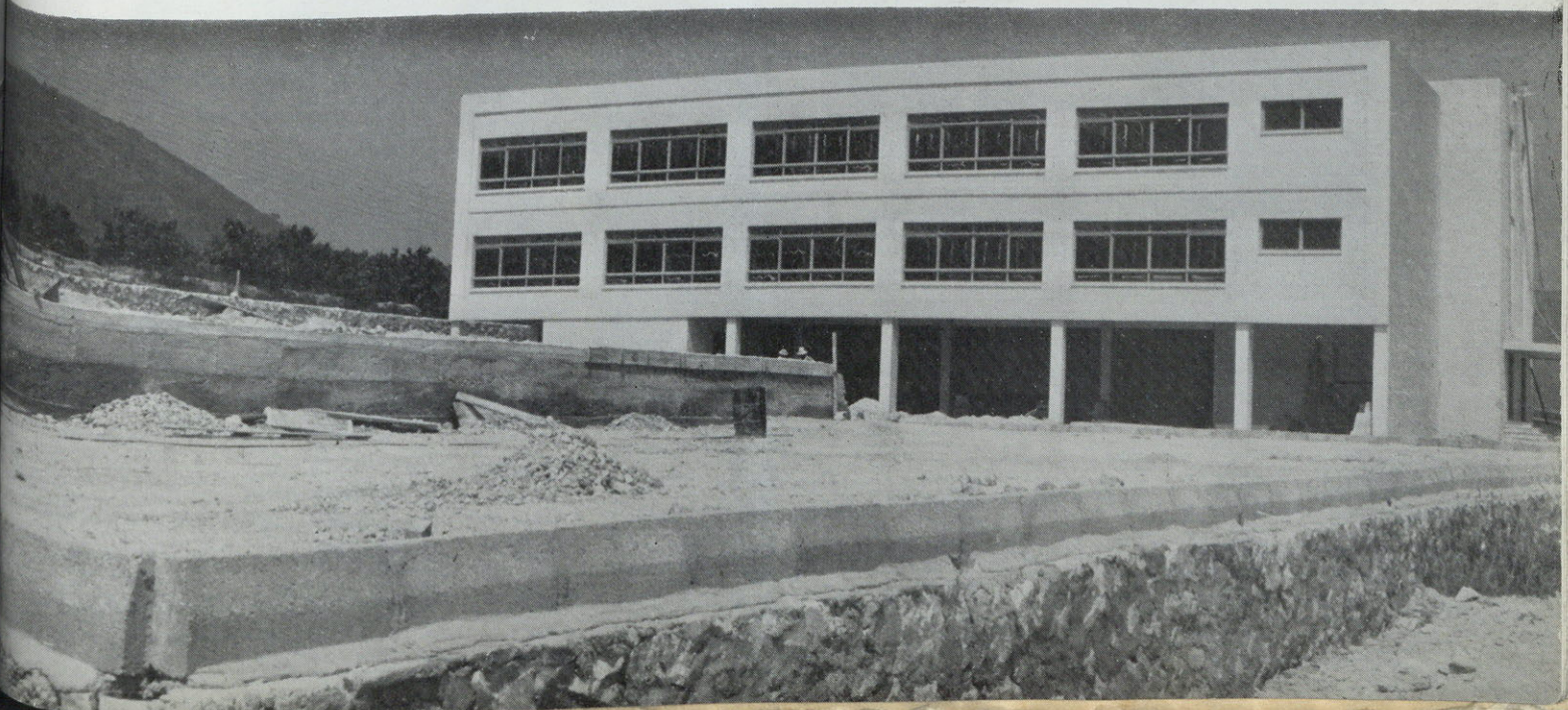
Vista del edificio en construcción del Colegio Nacional Cervantes
